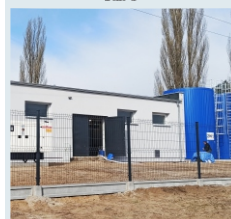
Kompleksowa modernizacja infrastruktury wodociągowej w Golinie str. 11
